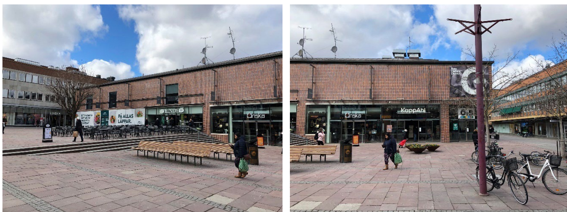
Figur 5. Gyllenhusets befintliga fasad mot Lilla torget med bränt beklädnadstegel och släta ljusa fogar. I bilderna syns moderna håltagningar för skyltfönster och ny skyltning som får anpassas om ändringarna förhåller sig till byggnadens ursprungliga utformning.
