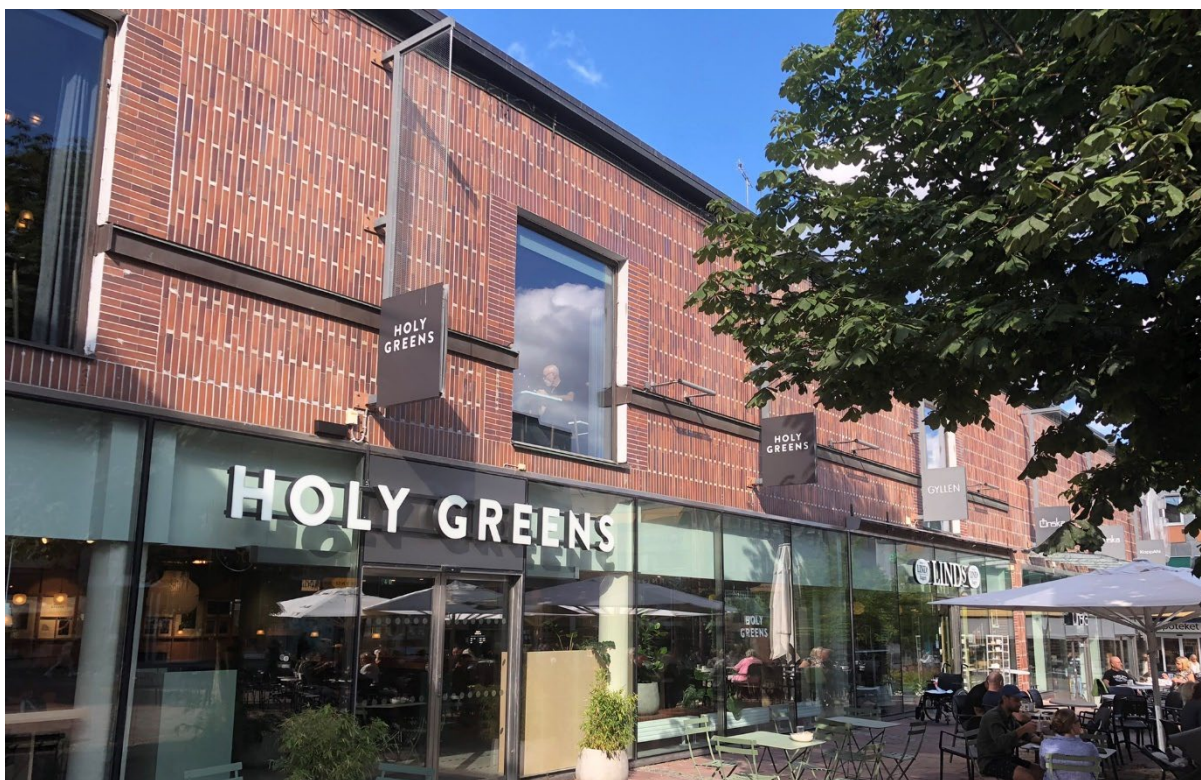
Figur 12. Bild som visar fasaden på den befintliga bebyggelsen i Dykaren 17 som vetter mot Lilla torget. Högst upp i bild syns den svarta takfoten, som är den karaktär som avses bevaras med bestämmelsen k_1 .
