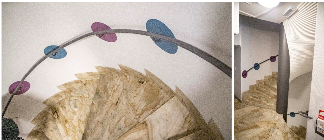
Figur 11. I den vänstra bilden syns smidesracket och trappstegen i marmor i detalj och till höger syns trapphuset som en helhet från entréhallen med marmorgolv, smidesräcke och veckat betongarbete på trappans undersida.
